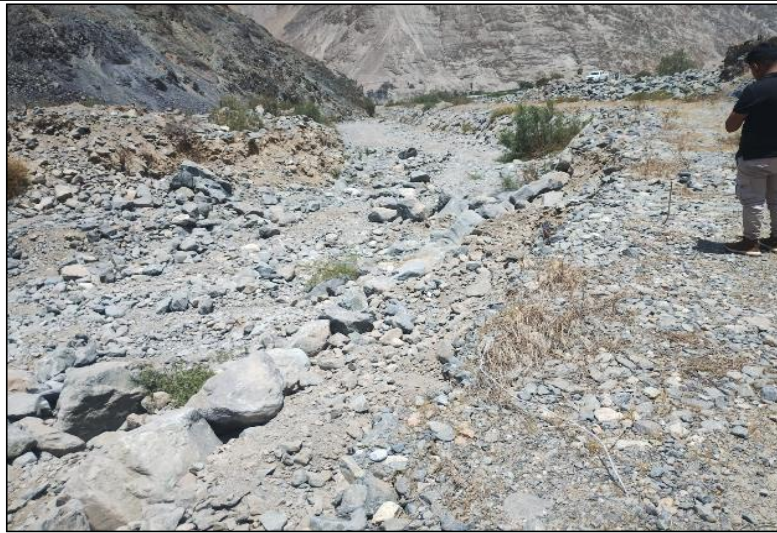
FIGURA N°02: CAUCE DE LA QUEBRADA HUAYANTO, SE OBSERVA COLMATADA Y SIN PROTECCIÓN EN SUS MARGENES
